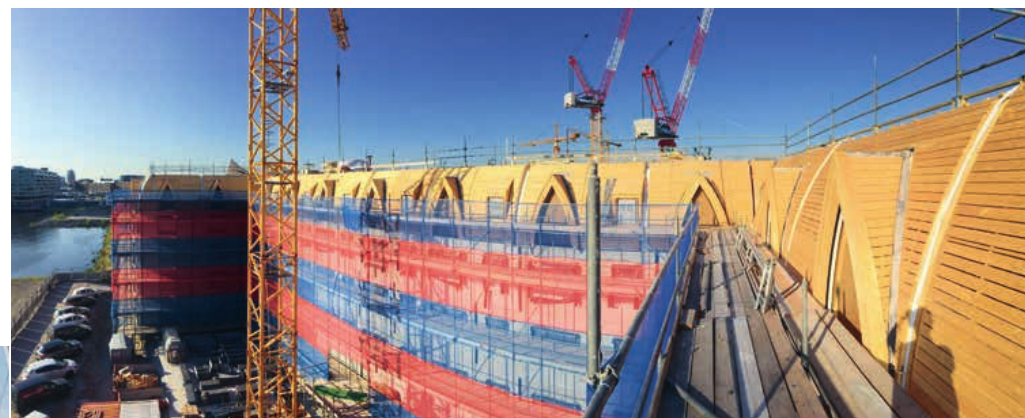
Prefab dakelementen staan op hun plaats (Foto: Ridder Skins for Buildings).
