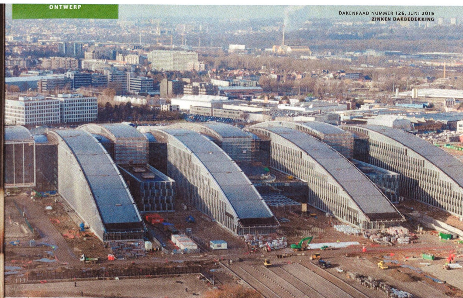
De longwings zijn circa 200 meter lang en hebben een getoogde vorm. De hellingshoek op het hoogste gedeelte is minder dan drie graden.
