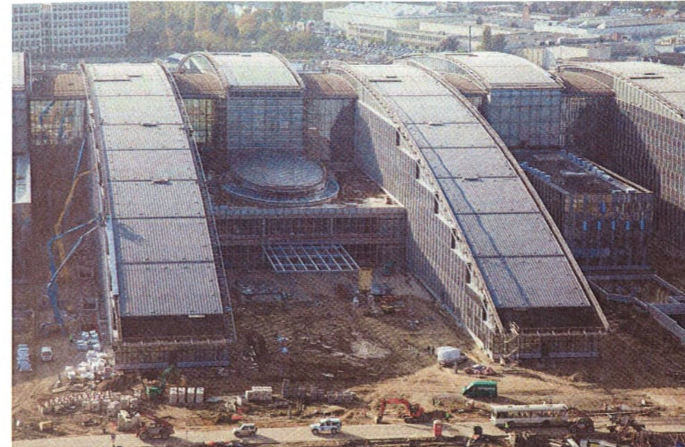
Het 200 meter lange dakvlak is opgedeeld in negen vakken, onderling gescheiden door gootconstructies. De felsbanen zijn op de grond vanaf de coils geprofileerd.
