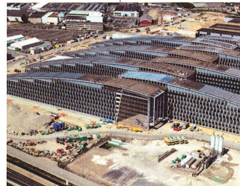
De tussenliggende eveneens getoogde dakvlakken van de agora, hier op de voorgrond net te zien, liggen lager dan de dakvlakken van de longwings. Het laatste dakdeel van de longwings loopt weer iets naar beneden.
